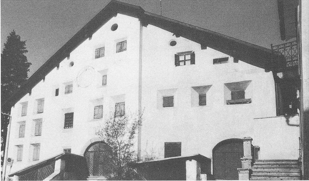
Doppelanlage am Dorfplatz, Nebenhaus
