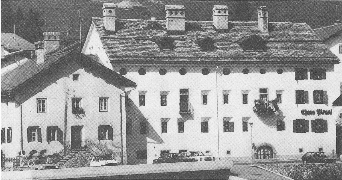
Bürgerhaus mit angegliederter Stallscheune
