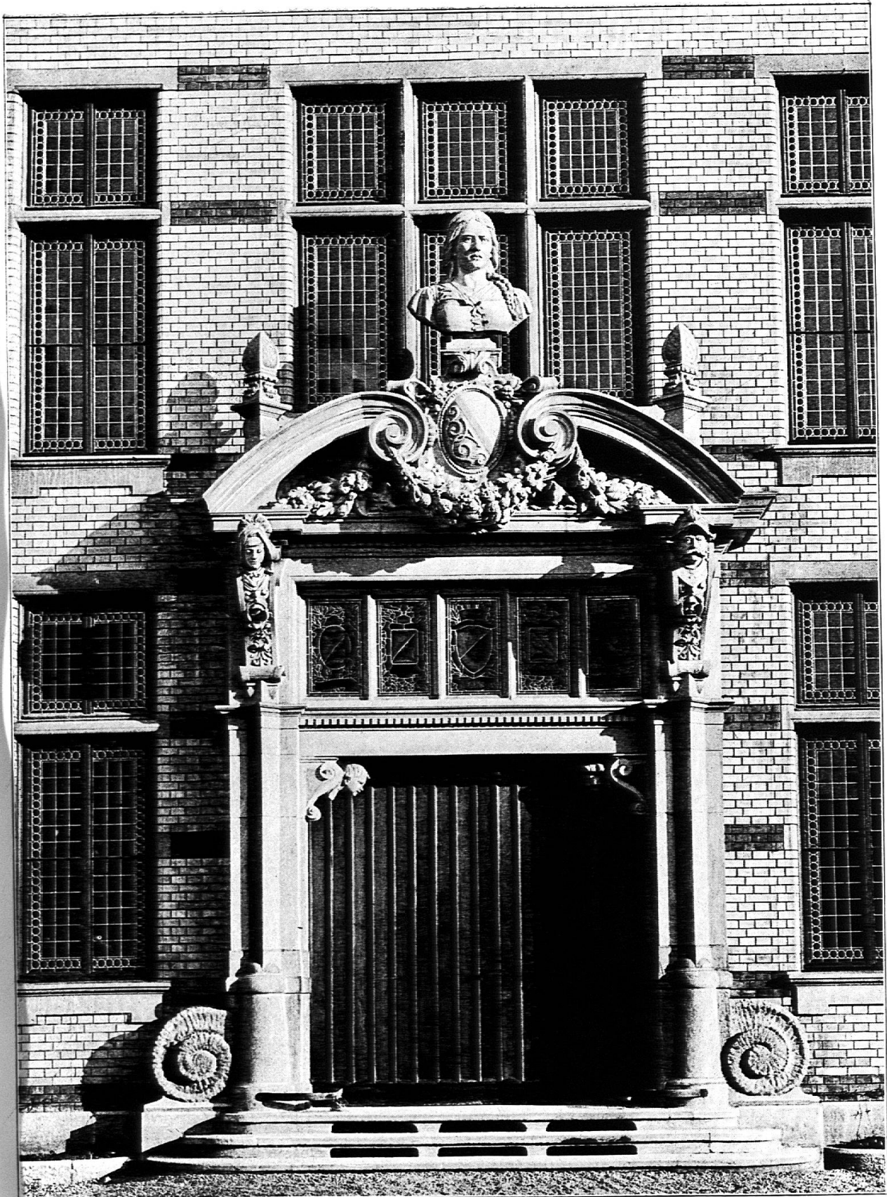
Portal am nordwestlichen Spielplatz.
