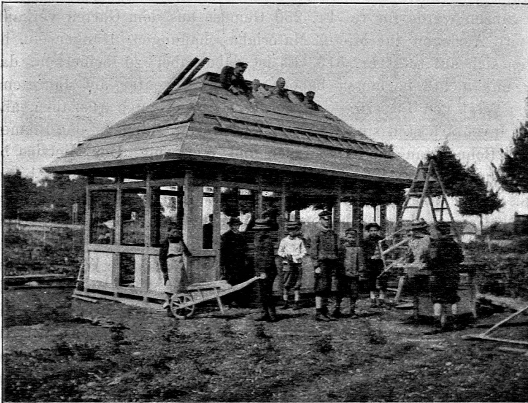
Aufbau des Gartenhäuschens.
