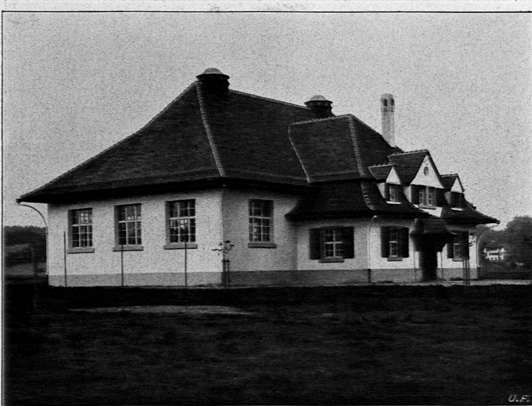
Die neue Turnhalle in Langenthal. — Außenansicht.
