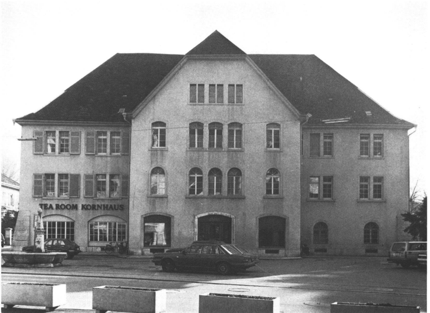
Abb. a: Das 1790 erbaute Kornhaus in Balsthal, Zustand bis 1985.
