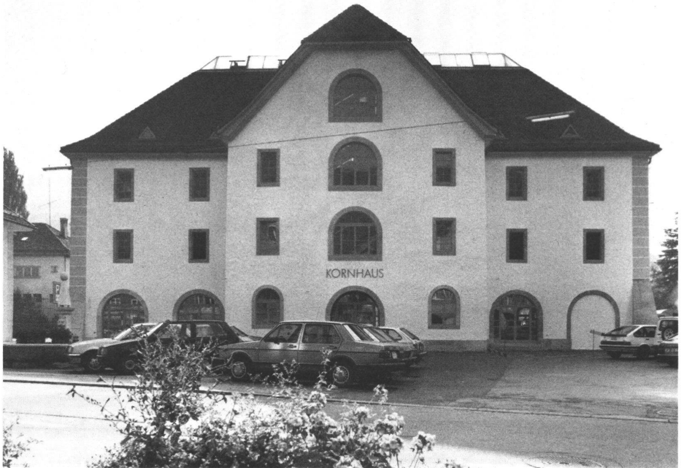
Abb. b: Das Kornhaus nach der Restaurierung.
