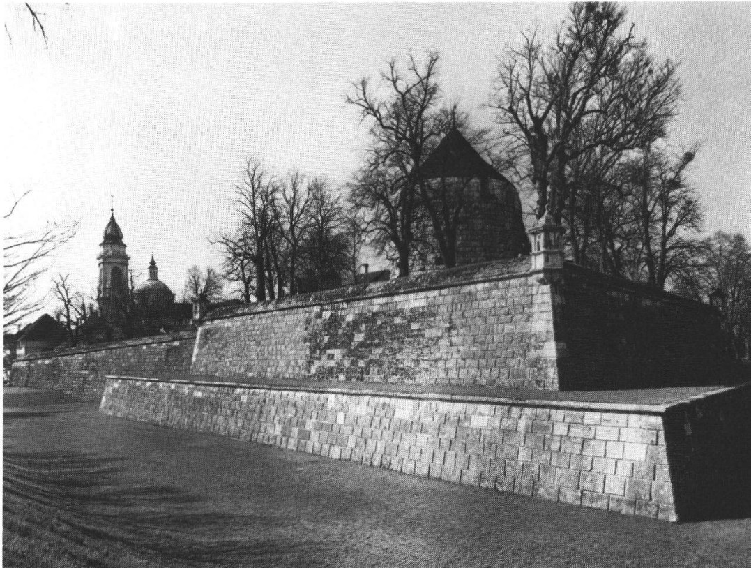
Abb. 8: Solothurn, St.-Ursen-Bastion von Nordosten mit Schanzengraben und Faussebraie (Niederwall).
