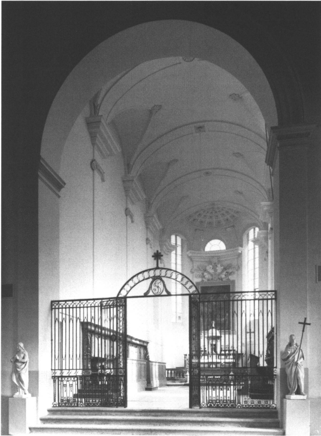
Franziskanerkirche: Der Chor in der klassizistischen Gestaltung von 1823–1825 (Zustand 1982).
