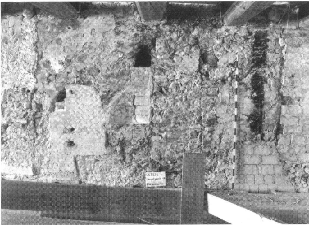
Abb. 3: Brandmauer Ost, 1. Obergeschoss, Mittelpartie. Jede Bauphase hat ihre Spuren hinterlassen. Die Entwirrung derartiger Befunde ist aufwendig, heikel, aber auch lohnend.
