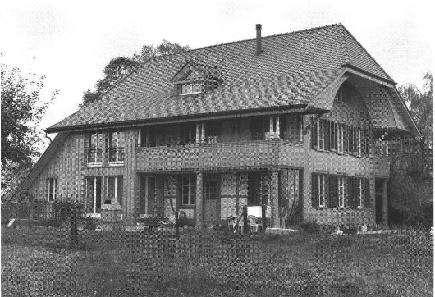
Abb. 2: ...und nach der Restaurierung.
