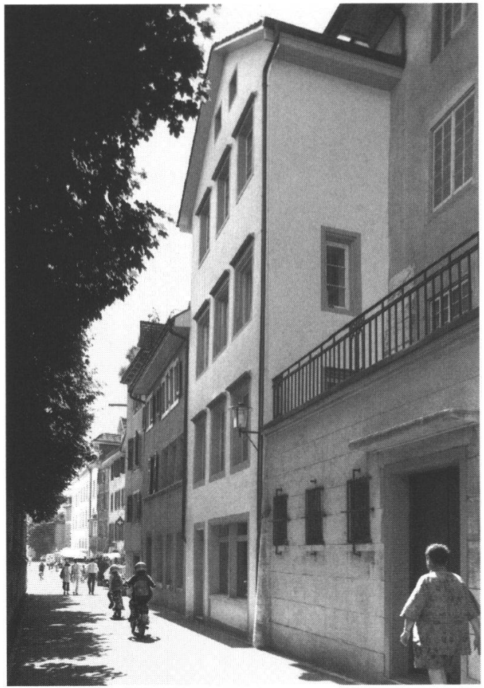
Abb. 2: Die Südfassade nach der Restaurierung.
