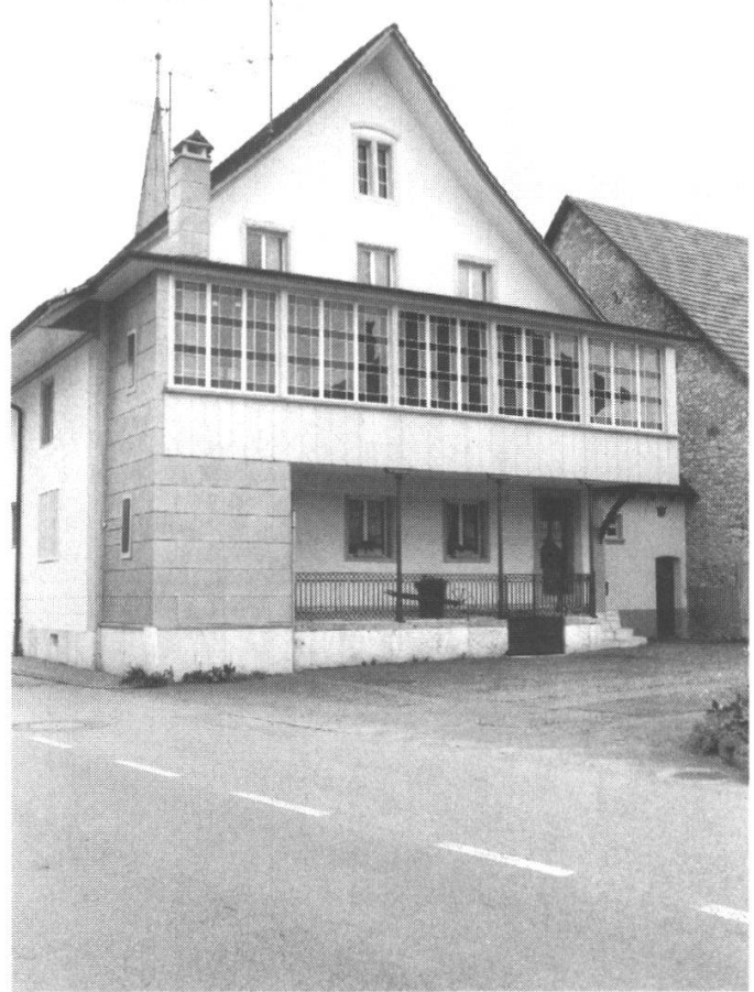
Abb. 2: Rückseite des Gasthauses mit verglaster Veranda.
