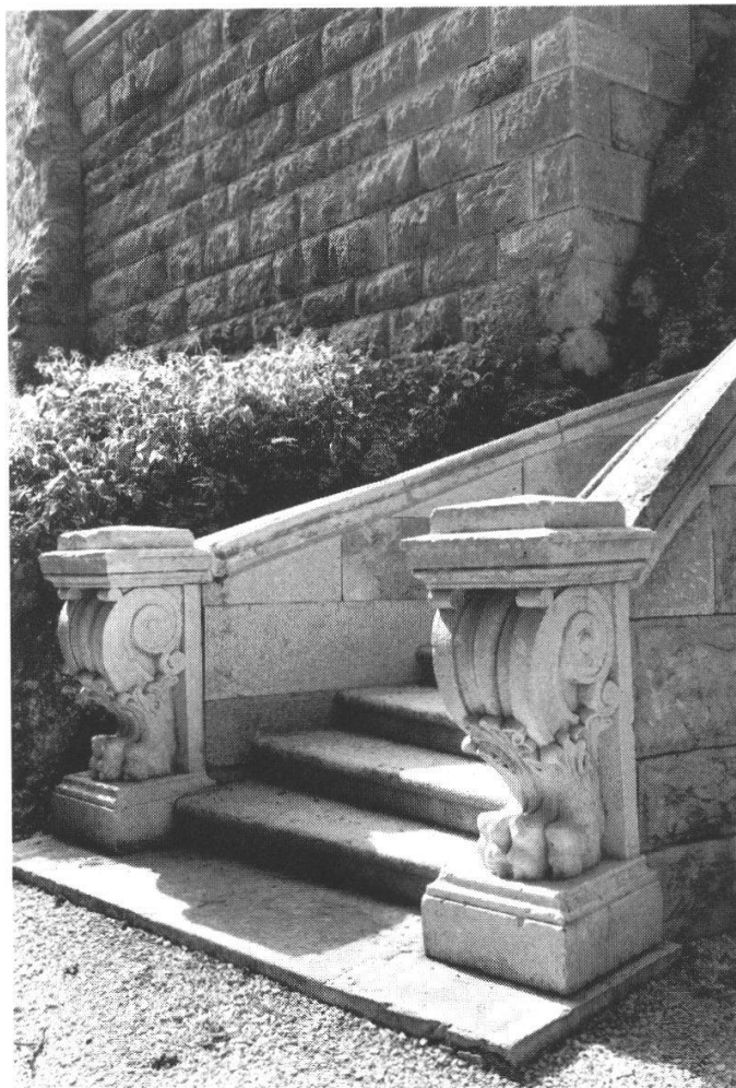
Abb. 4: Postamente der unteren Treppenanlage.
