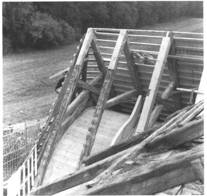
Abb. 10: Dachuntersicht des Hauptdaches mit profilierten Stichbalken.
