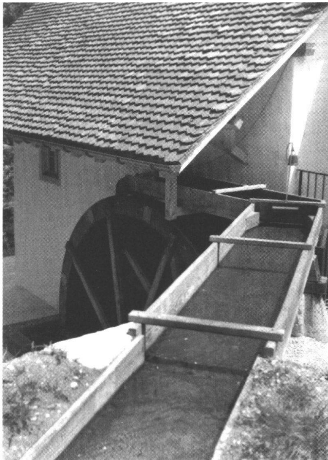
Abb. 6: Oberschlächtiges Wasserrad mit Zulaufkanal.
