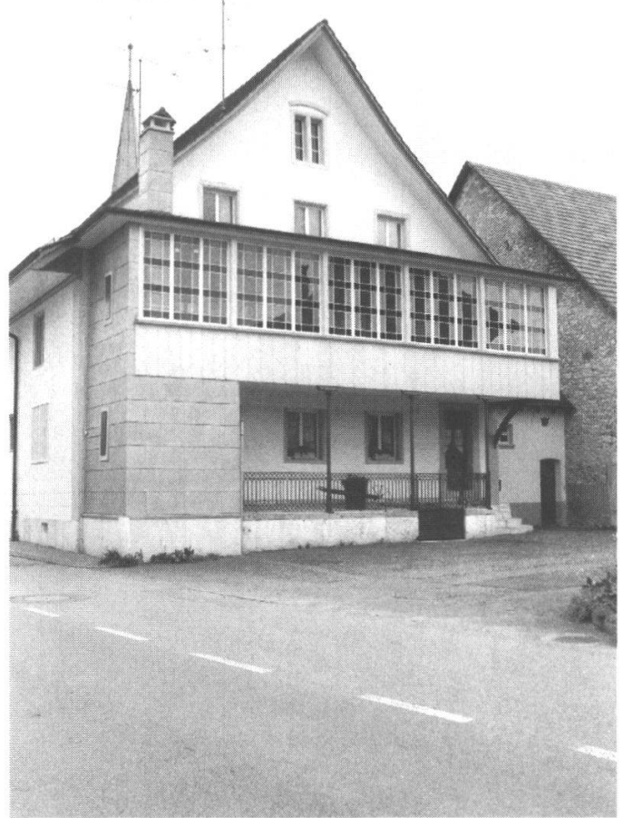
Abb. 2: Rückseite des Gasthauses mit verglaster Veranda.
