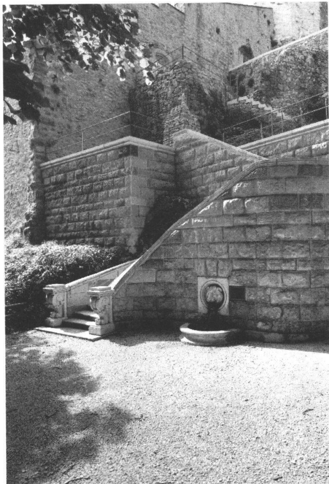
Abb. 3: Untere Terrasse mit Stützmauer von 1867.
