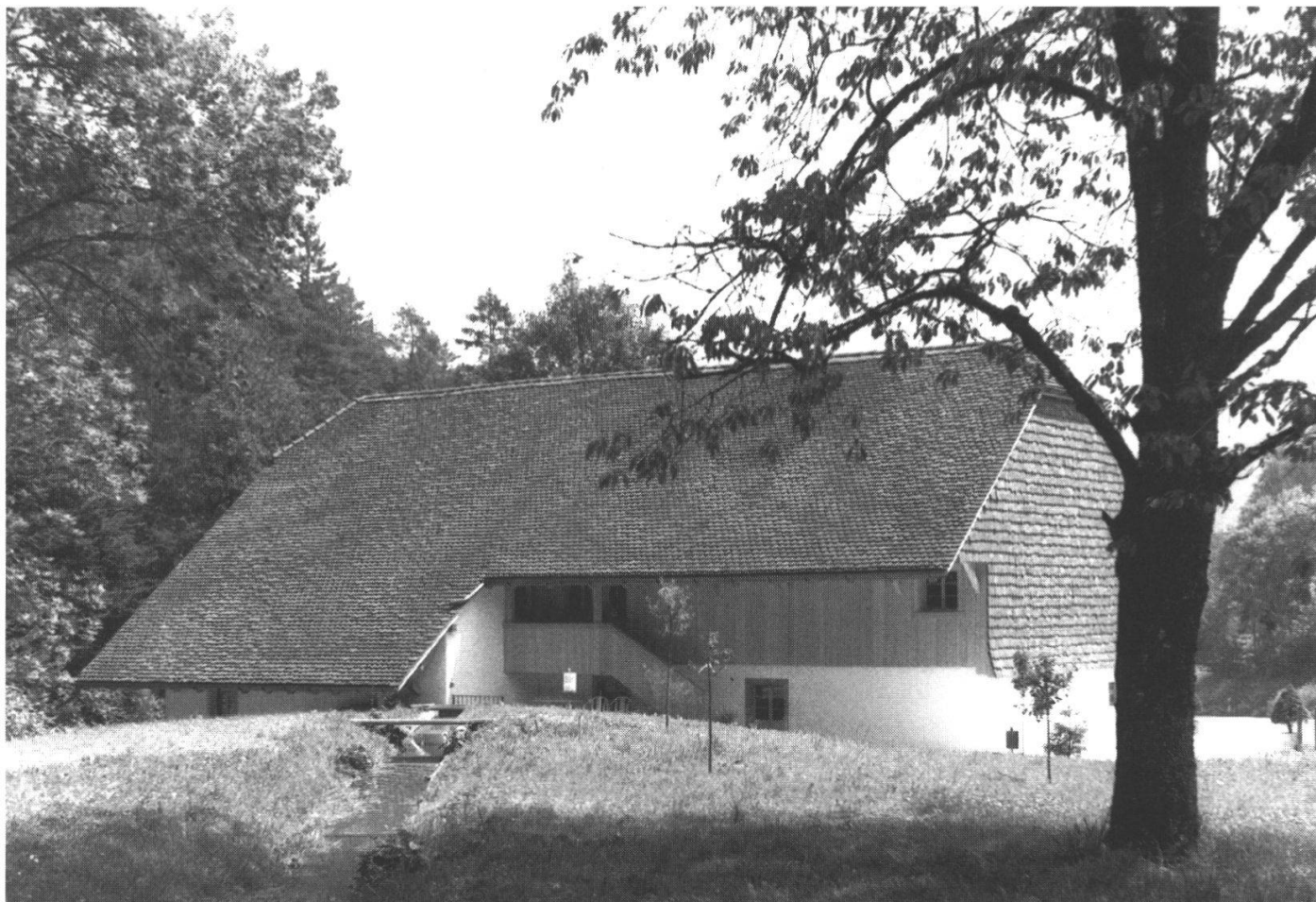
Abb. 2: Rückfassade nach der Wiederherstellung des Wasserkanals.
