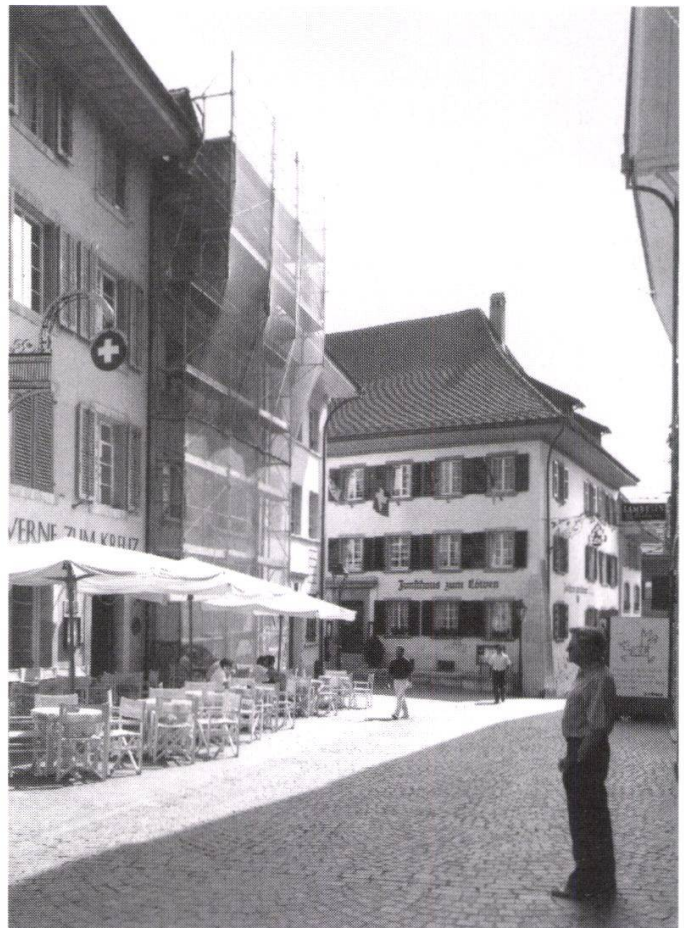
Abb. 2: Das Haus Hauptgasse 14 während des Umbaus.
