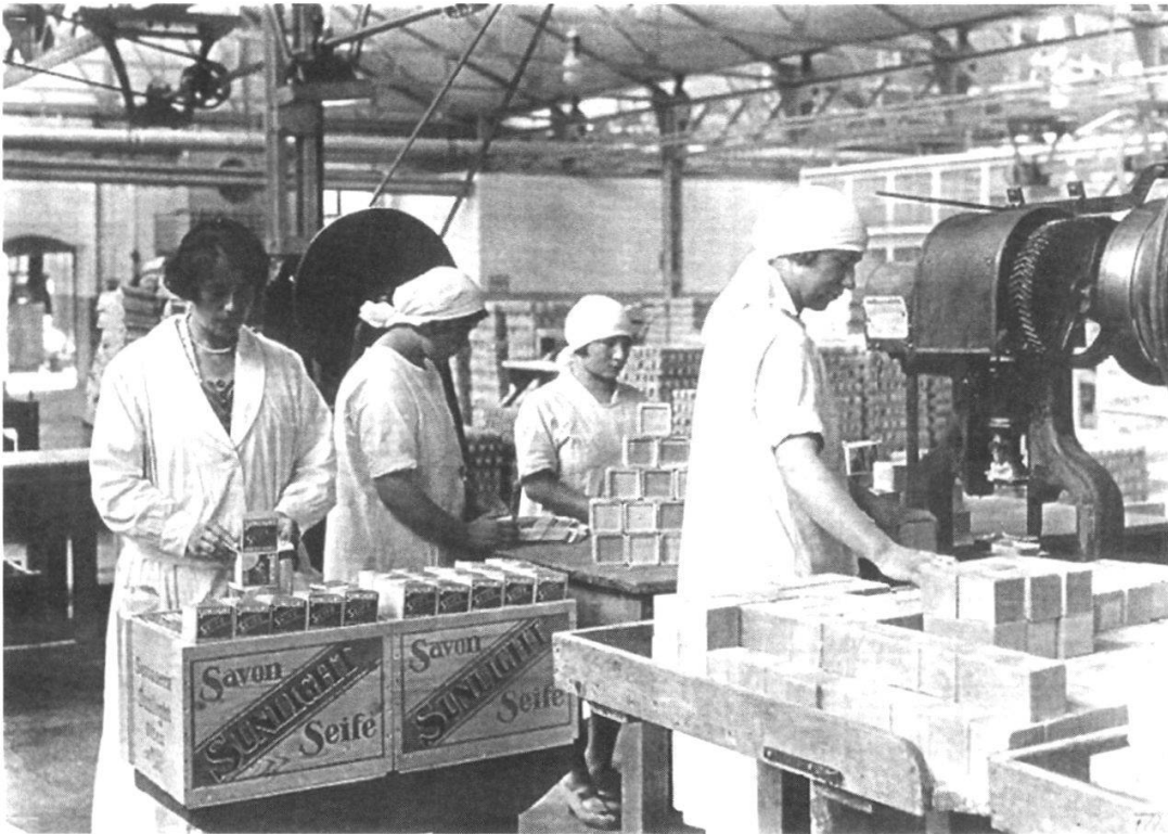
Abb. 12 Stempelsaal Seifenfabrik Helvetia 1930. Fotoalbum, A 268. 1908 verzeichnete die Plant Valuation eine handbetriebene Stempelmaschine, die das Stempeln von 600 Seifen pro Stunde erlaubte und zwei Rotationsmaschinen, die je 1500 Seifen pro Stunde stempelten. 1917 kam eine automatische Stempelmaschine mit einer Leistung von 2700 Seifen pro Stunde dazu. Die aus Port Sunlight übernommene Schneidmaschine zerlegte 1.2 Tonnen Seife pro Stunde. StAO FA HVS 02. A 246. Plant Valuation.
