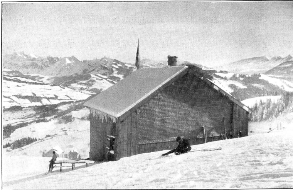
Stangenhütte (links hinten Säntis, rechts Churfirsten). Ski-Club Winterthur.
