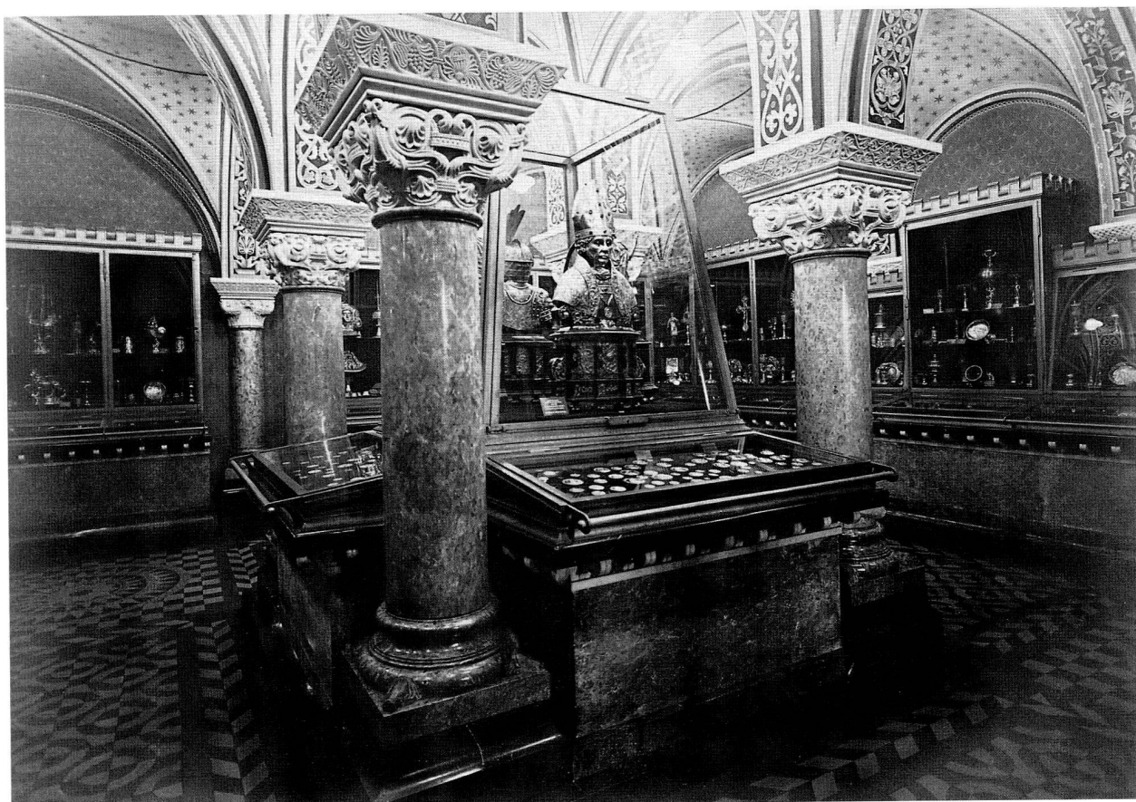
Abb. 65 «Schatzkammer» im Untergeschoss des Westflügels (Raum 10) im ursprünglichen Zustand von 1898.
