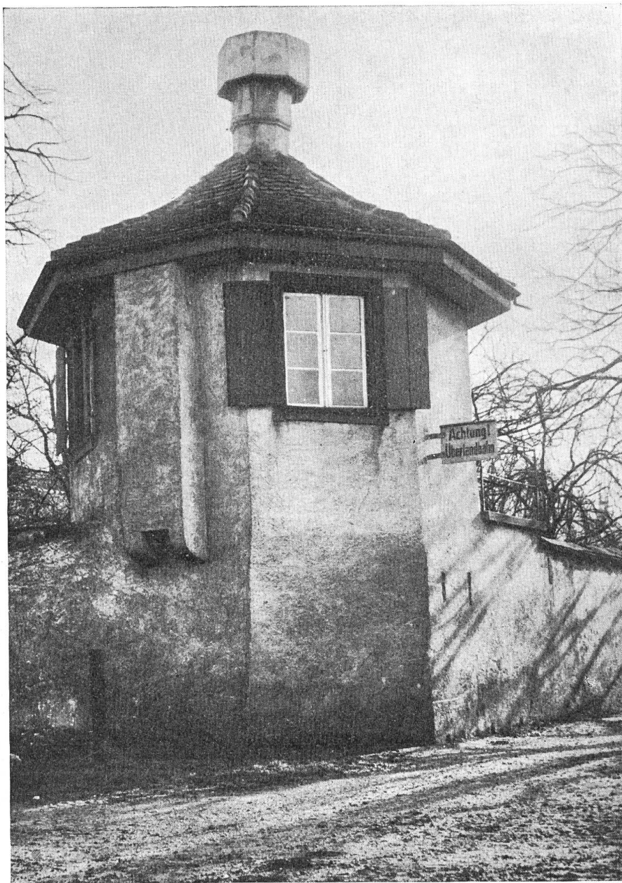
Muttenz. Gartenhäuschen beim „Hof“.
