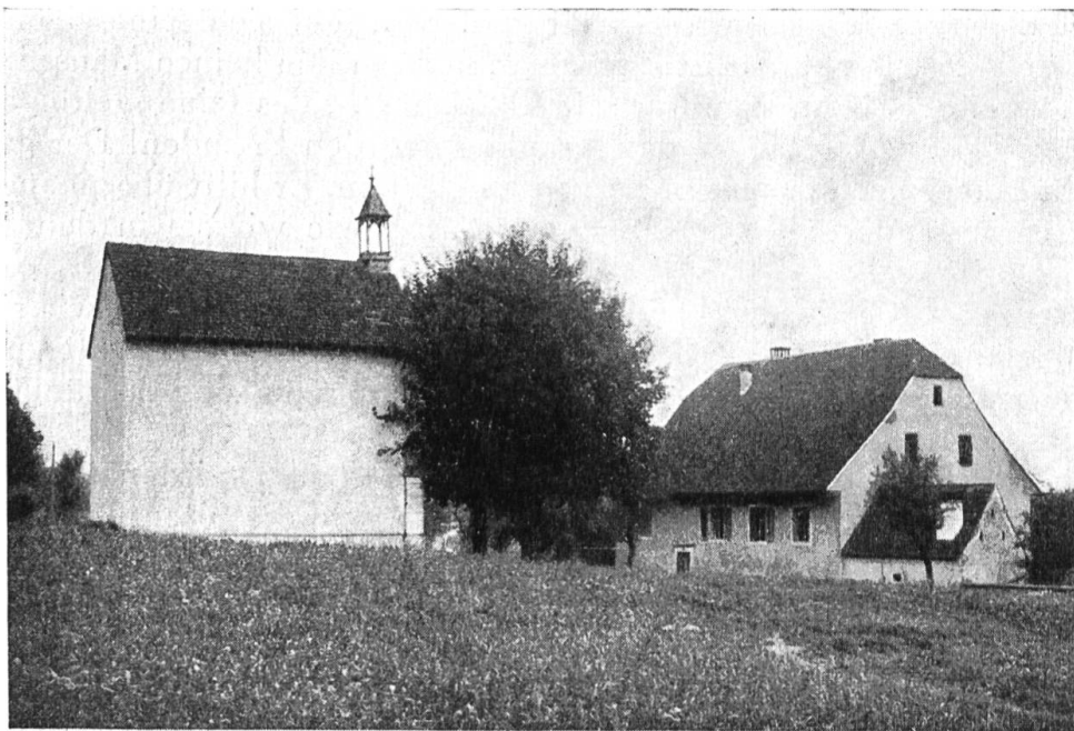
Kapelle und Propstei Rohr.
