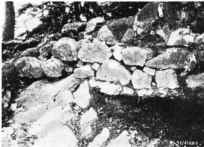
Südlicher Felssporn. Auf älterer Kulturschicht auf ruhende Mauer
