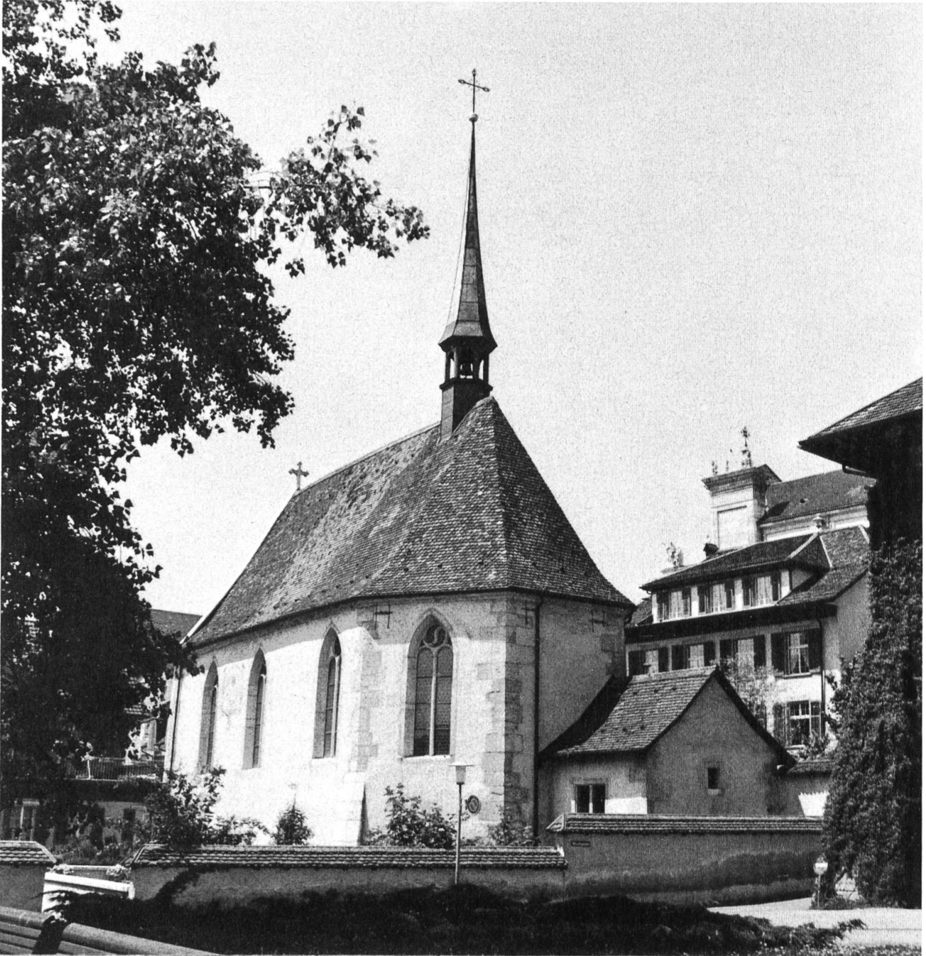
Die Peterskapelle, Ansicht von Südosten, Mai 1982.
