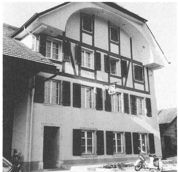
Gasthaus «Sonne», Niederbuchsiten, nach der Restaurierung.
