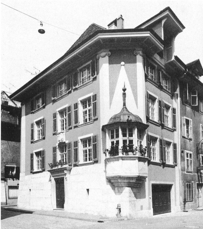
Das Zunfthaus zu Schiffleuten, nach der Renovation. Foto Studio Faisst Solothurn.
