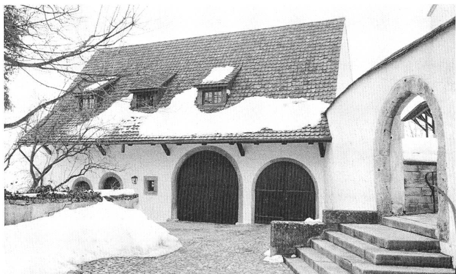
Oltingen. Pfarrscheune, erbaut 1910. Seit dem Umbau im Erdgeschoss Heimatmuseum und im Obergeschoss ein Saal.
