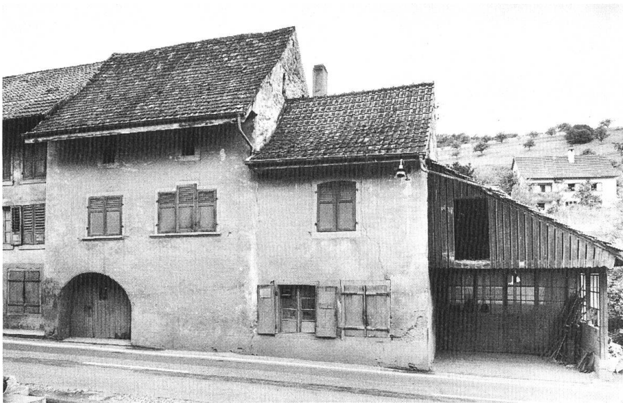
Bubendorf. Alte Schmiede, erbaut 1664, abgebrochen 1985.
