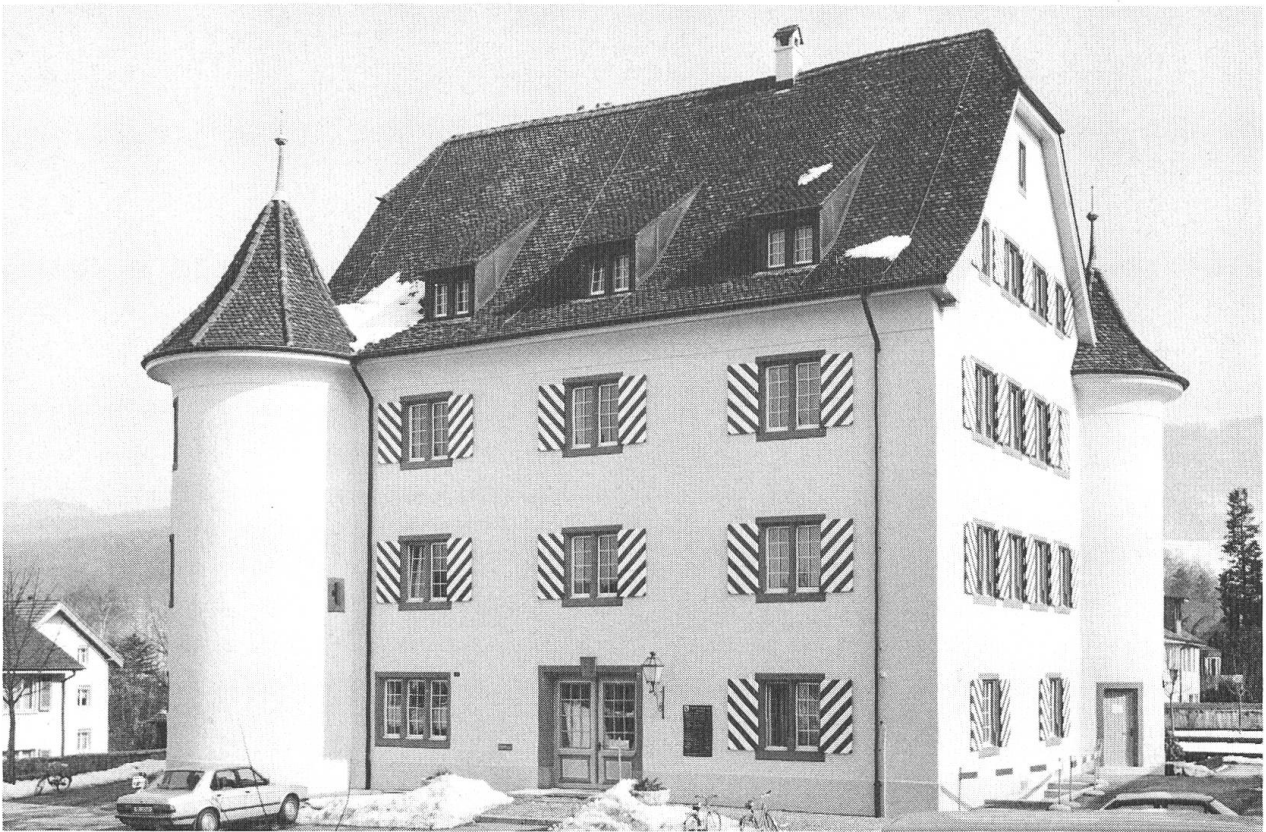
Aesch, Blarerschloss, erbaut 1604–07, als Gemeindehaus umgebaut 1958–59. 1985 mit neuen Fenstern und Läden versehen.
