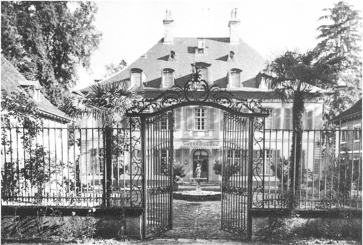
Sissach. Schloss Ebenrain, erbaut 1774–1776. Die vom Landrat 1985 beschlossene Gesamtrestauration soll 1986 beginnen.
