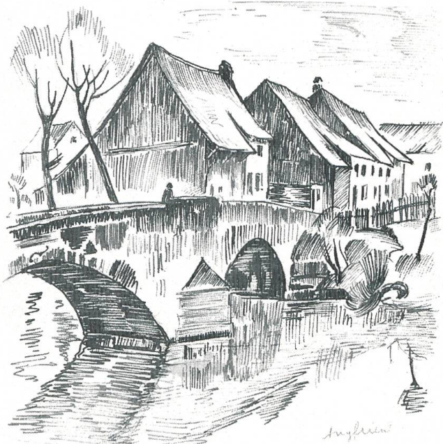
Zwingen, Alte Birsbrücke, abgebrochen 1959.
