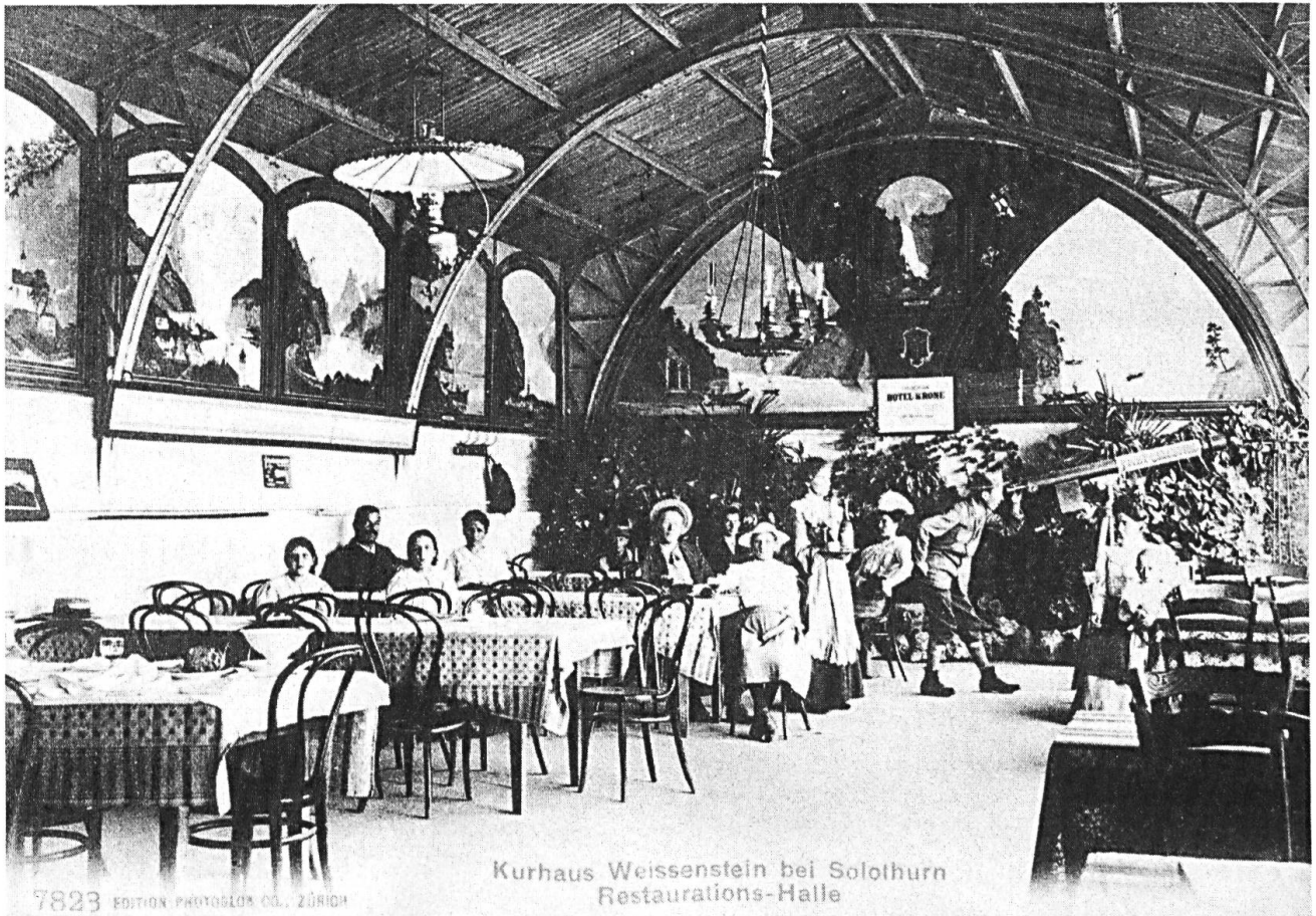
15 Inneres der Trinkhalle, wie sie sich zu Beginn unseres Jahrhunderts präsentierte (Blick gegen Osten).
