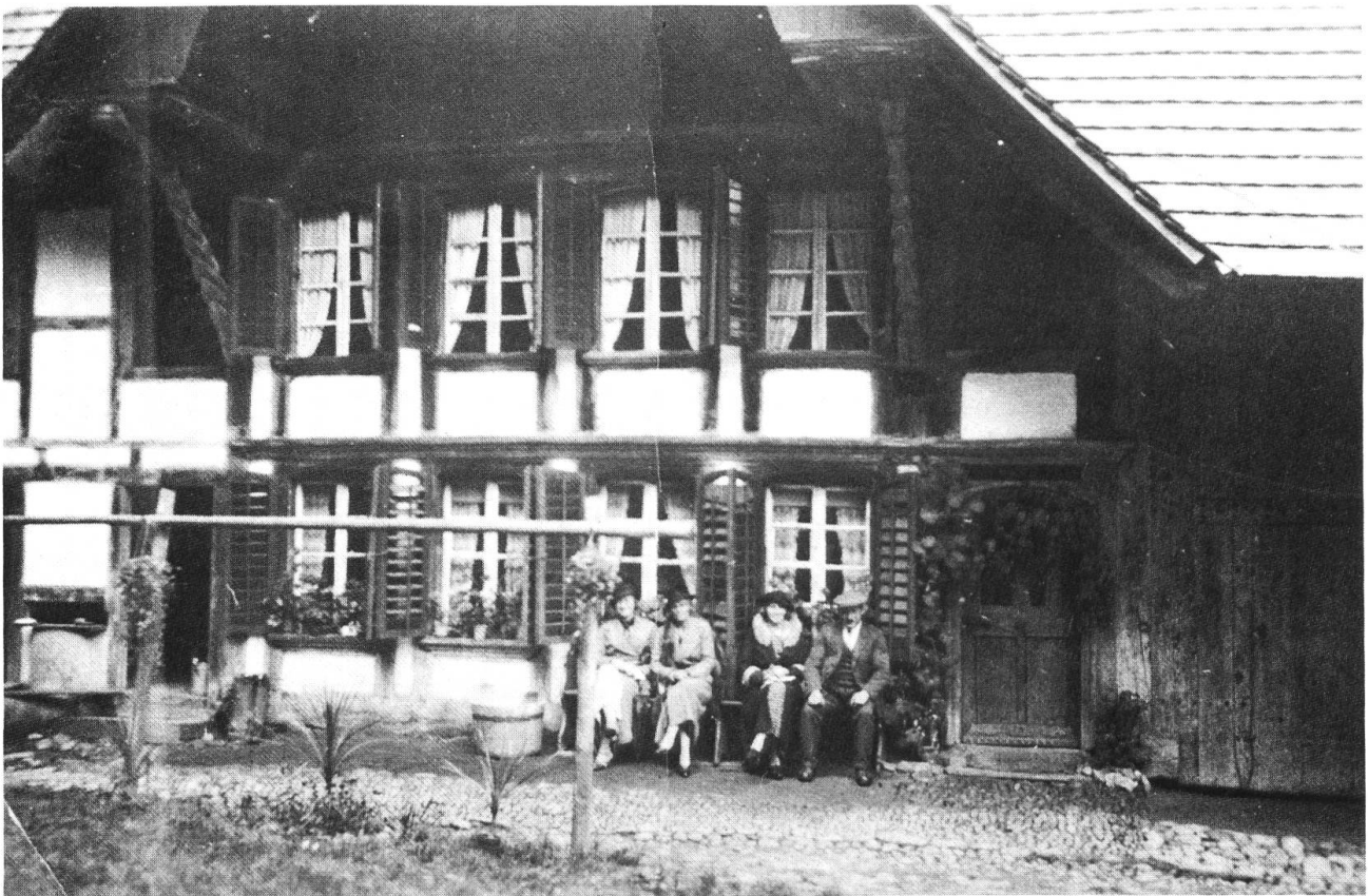
Älteste vorhandene Abbildung der Südfassade (Herbst 1934).
