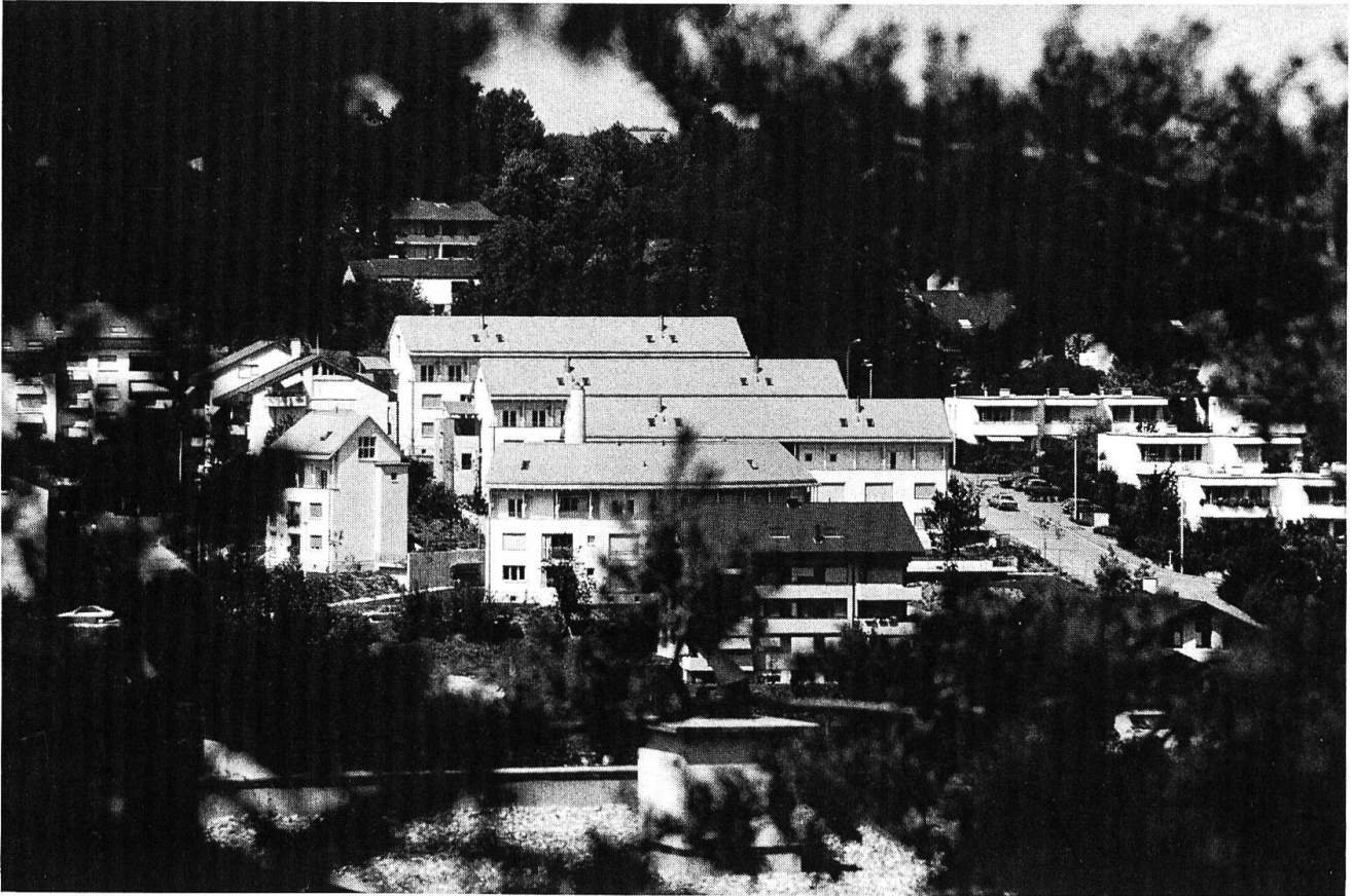
Überbauung «Unterm Stallen»
