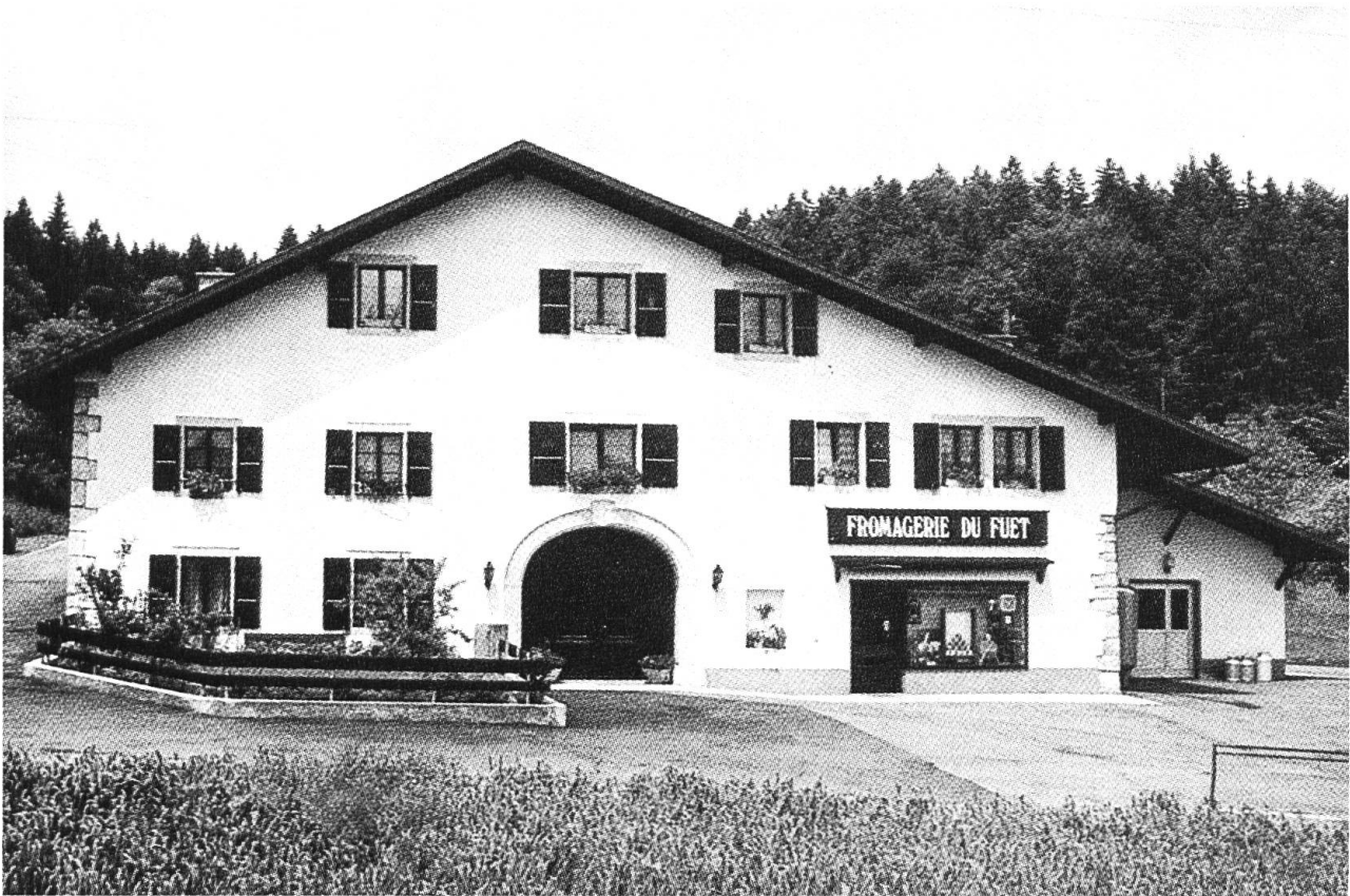
Bild 11: Die Käserei in Le Fuet wurde 1978 zu einem modernen Tête de Moine-Fabrikationsbetrieb umgebaut
