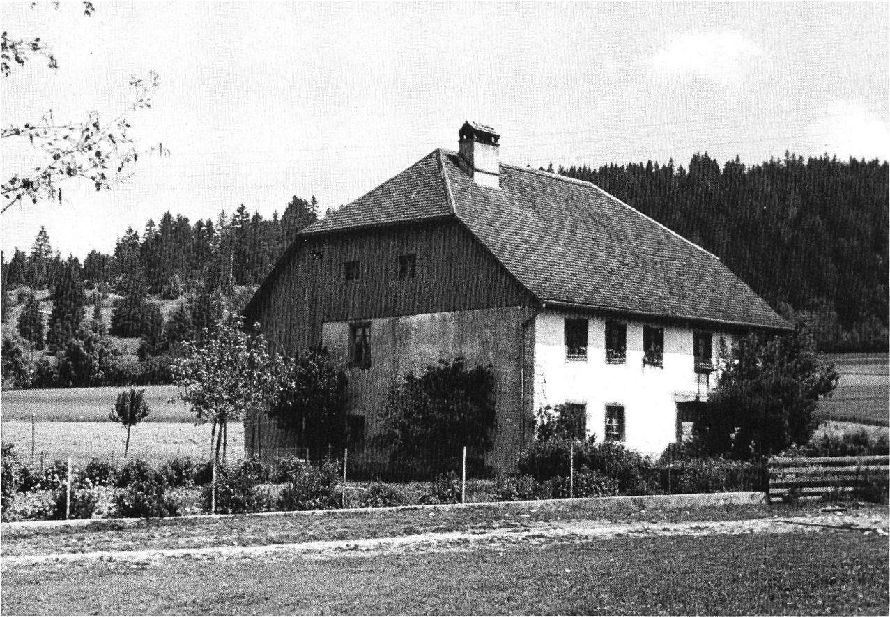
Bild 4: Vermutliches Gebäude der «Vacherie de Bellelay»
