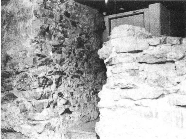
Abb. 8. Durchbruch durch die «Innere» Stadtmauer im Bereich des Anschlusses an die Südwestecke des Turmes.
