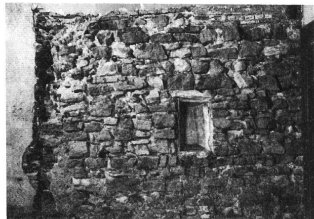
Abb. 6. Schlitzfenster in der östlichen Turmwand, 2. Stock.
