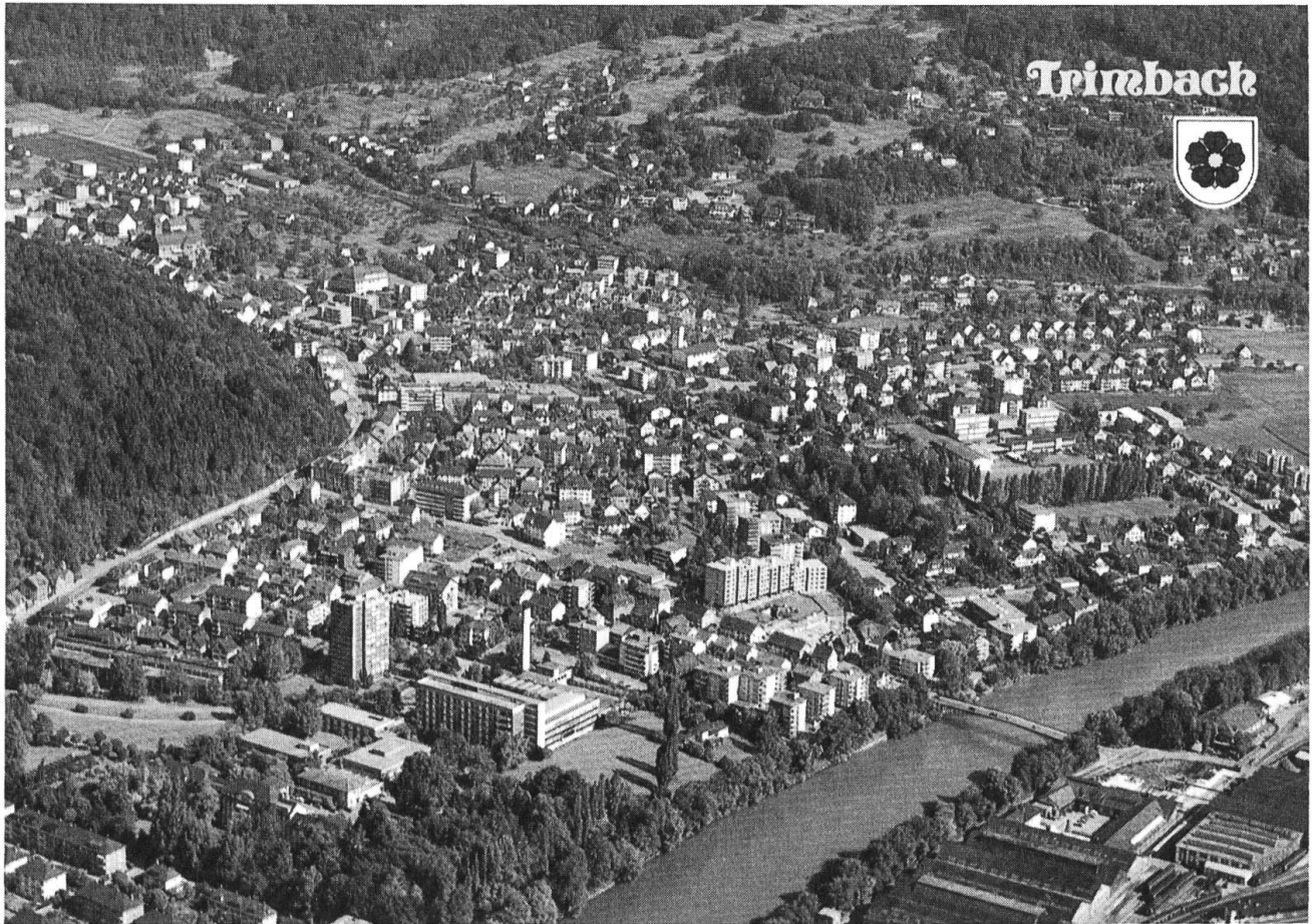
Trimbach um 1990: Vordere Mitte: Kantonsspital Olten — Schwesternhaus (Hochbau) und Dienste (hoher Kamin) stehen auf Trimbacher Boden. — Rechter Bildrand: Schulhäuser Leinfeld (hinter Sportplatz) und Gassacker I und II. — Mitte: reformierte Johanneskirche, links davon Kirchfeld und anschliessend Schulhaus Mühlematten. Weiter links: katholische Mauritius-Kirche und christkatholische Kreuz-Kirche (leicht aus den Bäumen herausragend). Schräg darüber Schulhaus Brüelmatt und dahinter, hinter dem Feld, Schulhaus Gerbrunnen.
