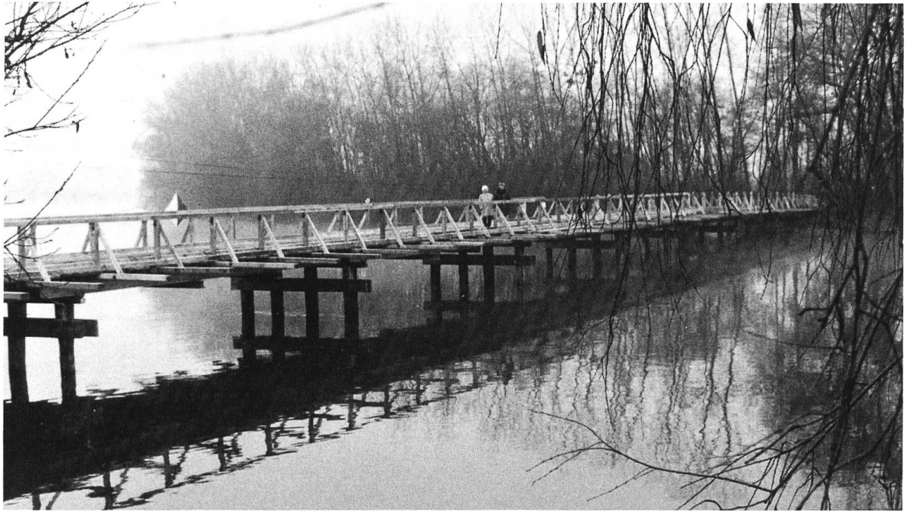
Im Winter 1991/92 wurde auf dem Inseli eine Hofsanierung vorgenommen. Für diesen Umbau hat das Genie Bat 22 innerhalb der Aktion «Gemeinsam» vorübergehend eine Holzbrücke erstellt.
