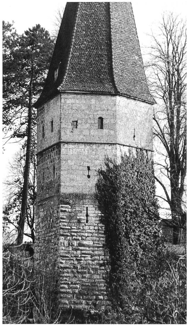
Solothurn, Krummturm: Ähnlich wie das Bieltor entstammen auch die bossierten Untergeschosse des Krummturmes aus Kalkstein dem 13. Jahrhundert und die glatten Tuffsteinobergeschosse dem 15. Jahrhundert, genauer der Zeit um 1462/63.
