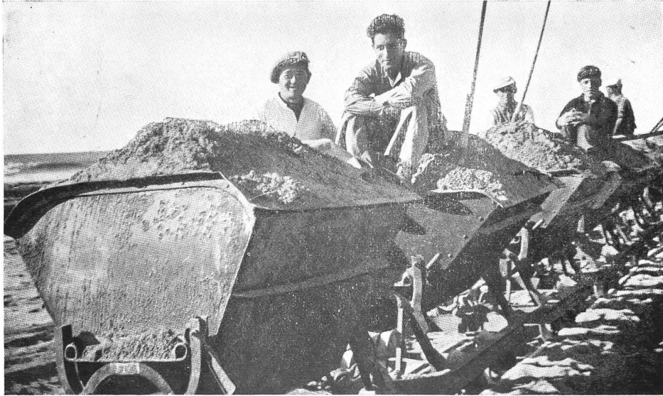
Jüdische Erdarbeiter in Palästina
