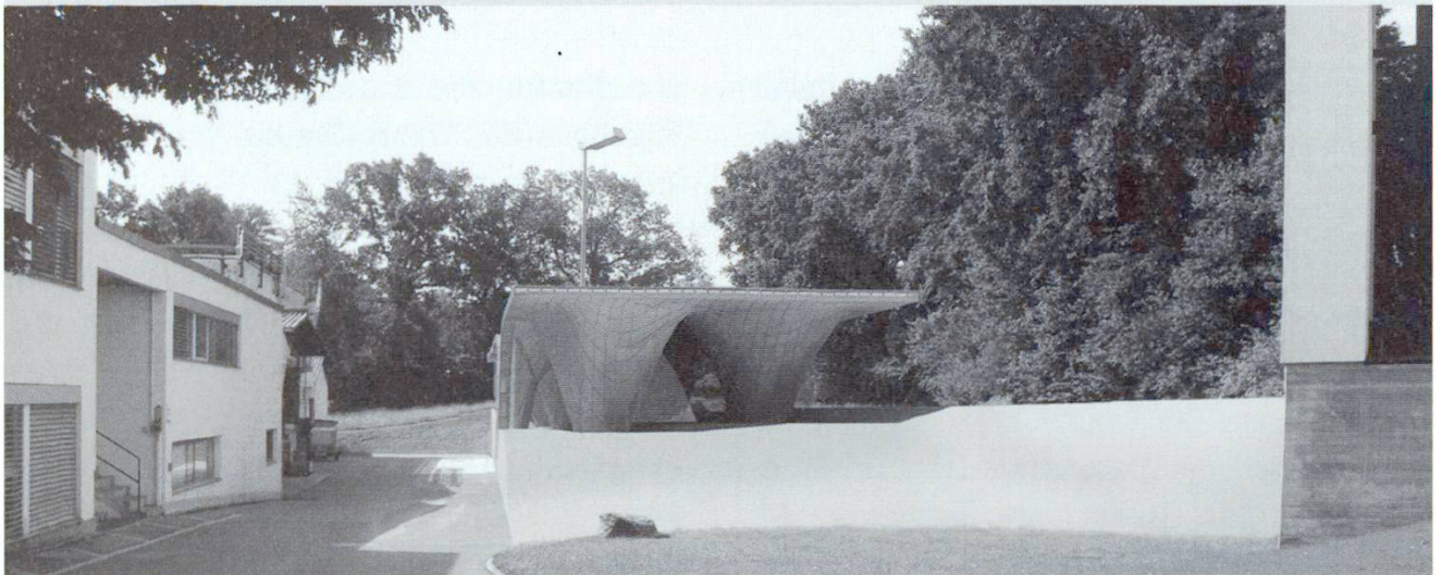
Lukas Hodel; Konstruktion in ausgeschäumter Textilmembran
