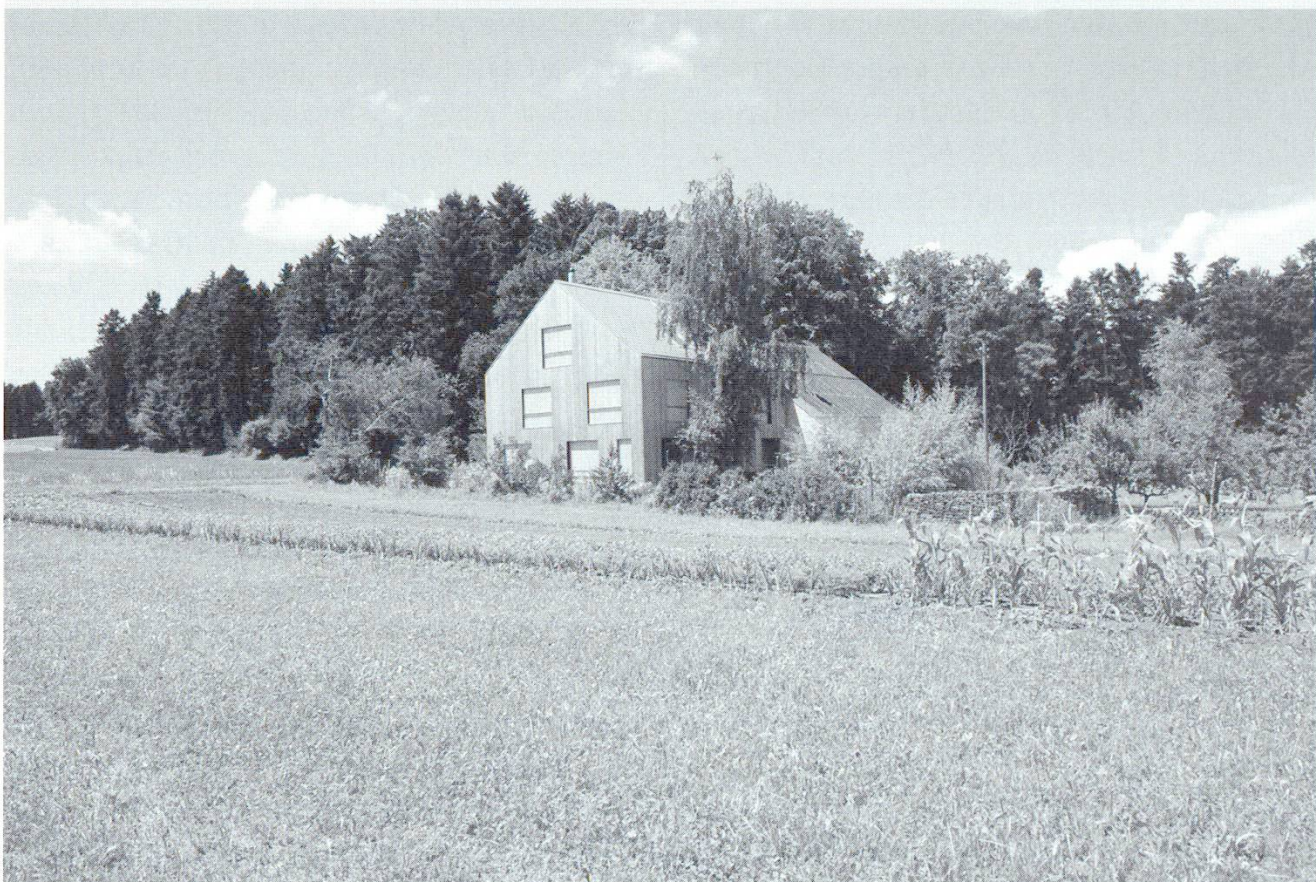
Lage: Grünboden, Pfaffnau Bauherrschaft: Annemarie und Kilian Blum Architekten: Blum + Grossenbacher Architekten AG, Langenthal Holzbau: schærholzbau AG, Altbüron Fotos: Markus Meier, Langenthal
