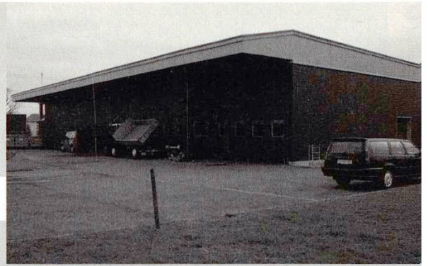
2. Rothenburg, Werkhof Oberhusrain: Das Schnittprofil der Träger gibt dem Holzbau ein ländliches Gepräge.
