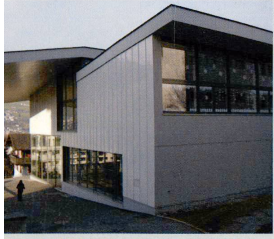
7. Buochs, Schulhaus Baumgarten: Das kräftig gefaltete Dach tritt beim Eingang über die Gebäudekante hervor.
