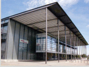
8. Zürich Oerlikon, Messe Zürich: Der gedeckte Vorraum wird stark von der Stützenreihe geprägt.
