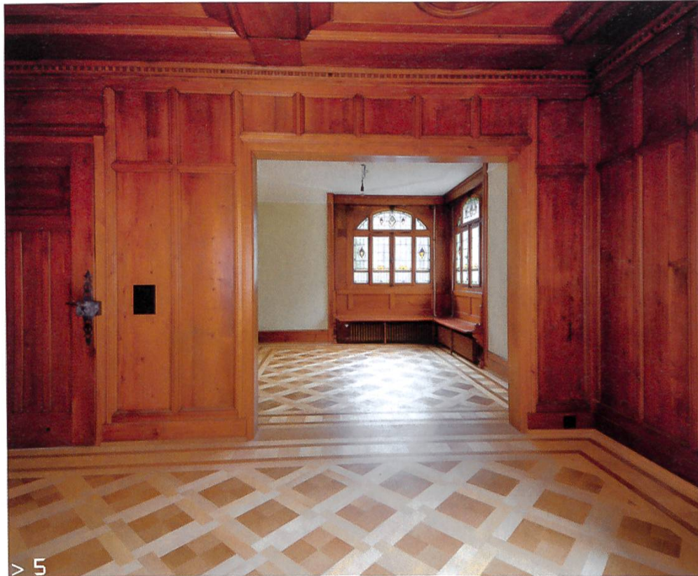
> 5 Salon: Blick vom Esszimmer in den Salon durch die nachträglich erweiterte Öffnung, die mit einer Schiebetüre durchaus auch aus der Bauzeit hätte stammen können.
