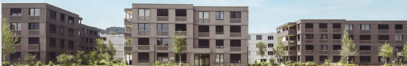
Überbauung Suurstoffi Risch Rotkreuz
