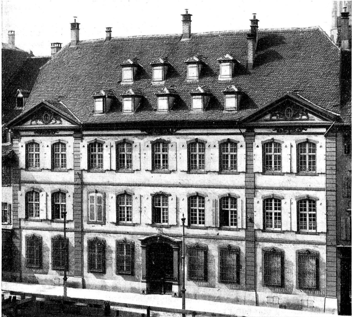
Basel, Haus zum goldenen Löwen. Fassade. 18. Jahrhundert. Zustand vor 1920.
