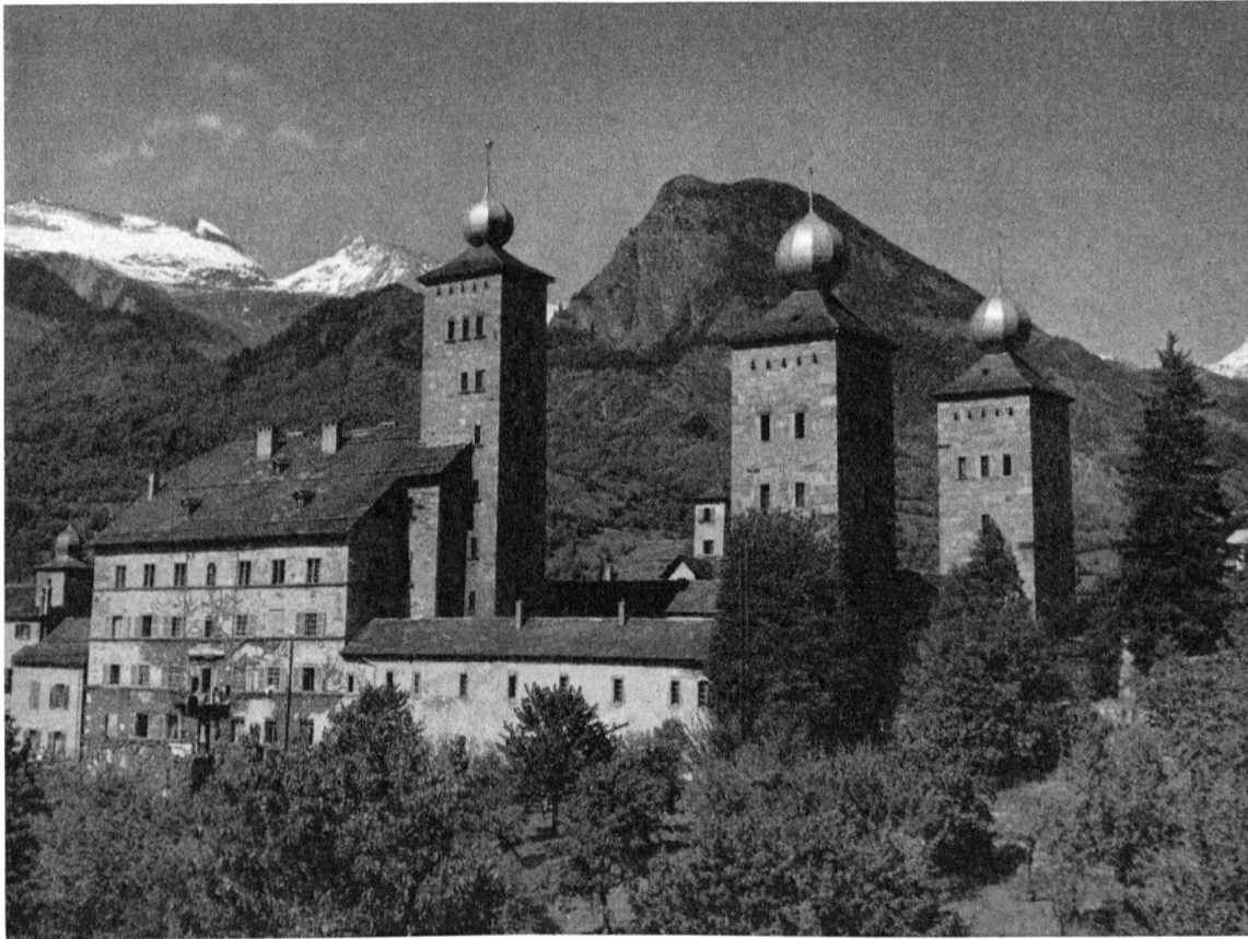
Brigue. Château de Stockalper. (Photo Lörtscher)
