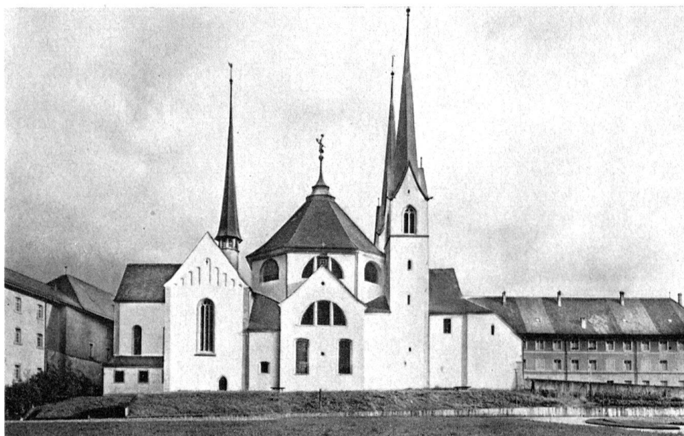
MURI: 1957 RESTAURIERT, 1960 VERBAUT?
