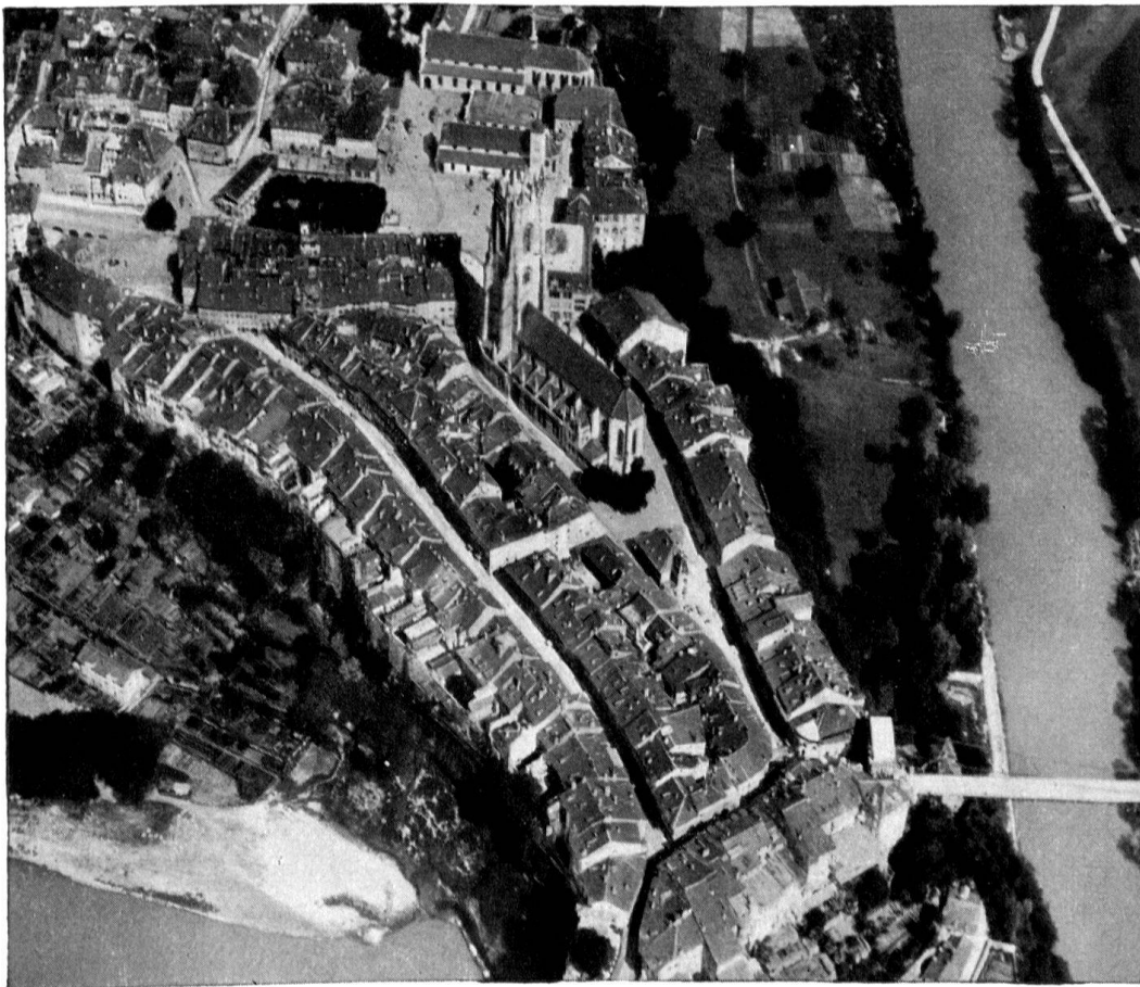
Freiburg i. Ue. Flugansicht von Süden
