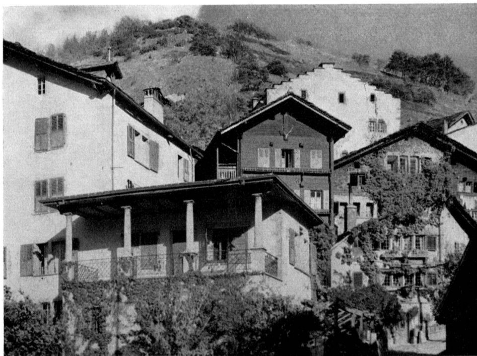
Rarogne: au fond, la façade, depuis longtemps fissurée de la maison Zentriegen. (Ulrich Ruffiner, 1513)
