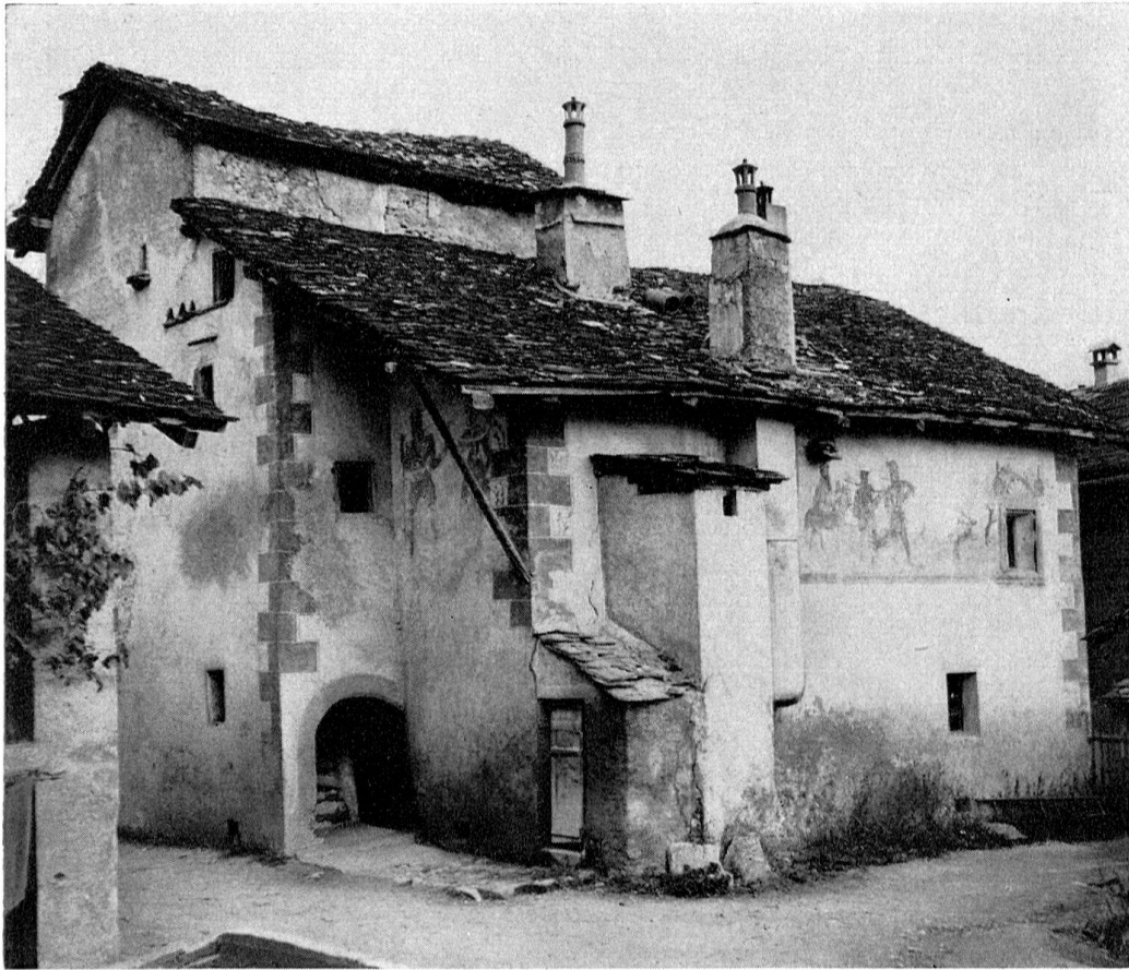
Vas: Ancienne auberge, construite en 1565 avec ses façades décorées de fresques
