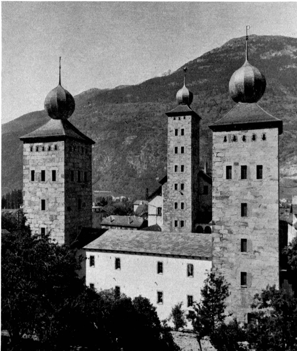
Brig, Stockalperpalast. Gesamtansicht von Süden
