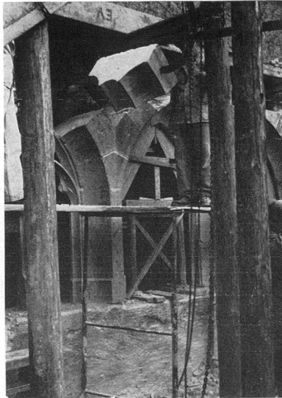
Einbau eines Bogenstücks mit der Greifzange (Ostflügel)
