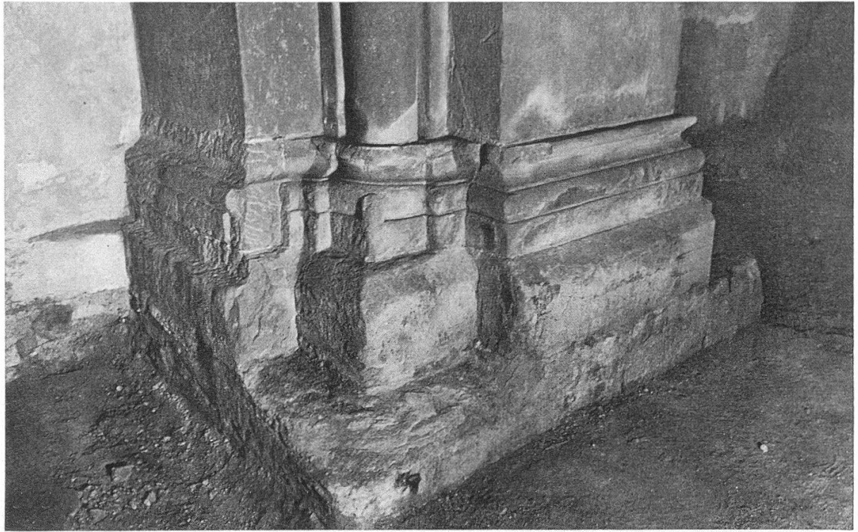
Kappel am Albis. Ehemalige Klosterkirche. Basis des nordwestlichen Vierungspfeilers vor der Restaurierung
