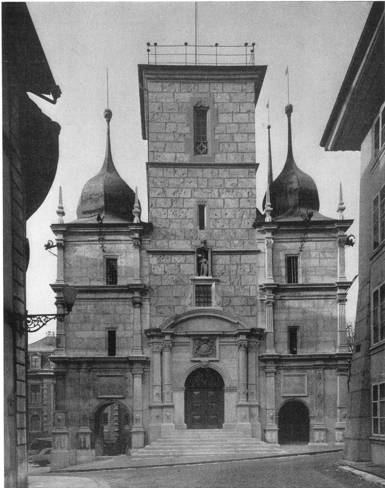
Solothurn, Rathaus. Hauptfassade nach der Restaurierung
