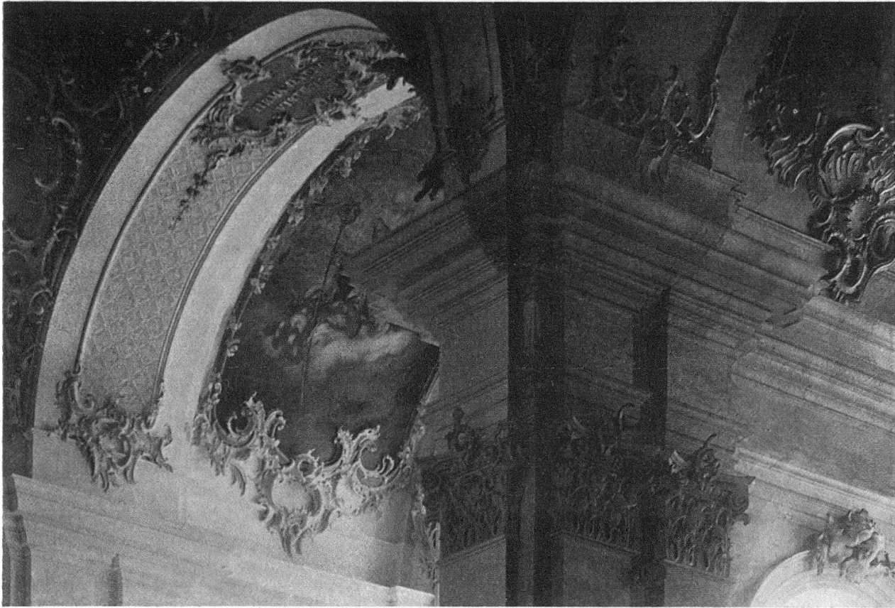
Stiftskirche St. Gallen. Blick in das freigelegte Gewölbe des nördlichen Seitenjochs im Schiff. Rechts die Übermalung von 1866
