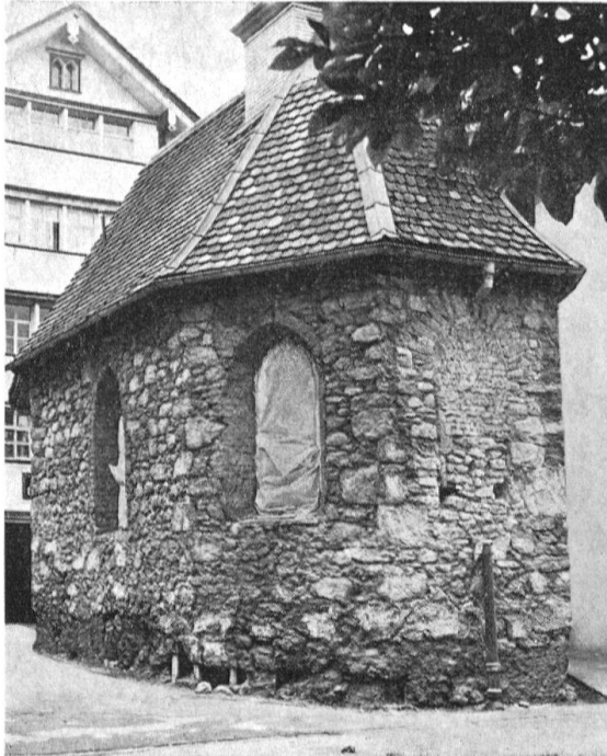
Appenzell. Kreuzkapelle. Äußeres während der Restaurierung nach Abschlagen des Verputzes und Inneres mit dem (inzwischen entfernten) hölzernen Abschlussgitter
