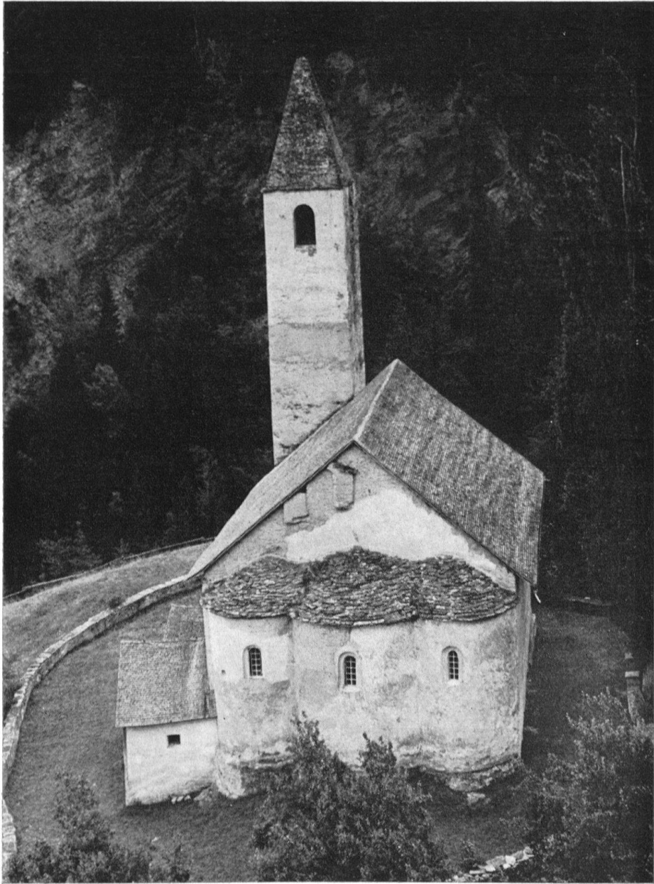
St. Peter in Mistail, Kanton Graubünden. Außenansicht von Osten
