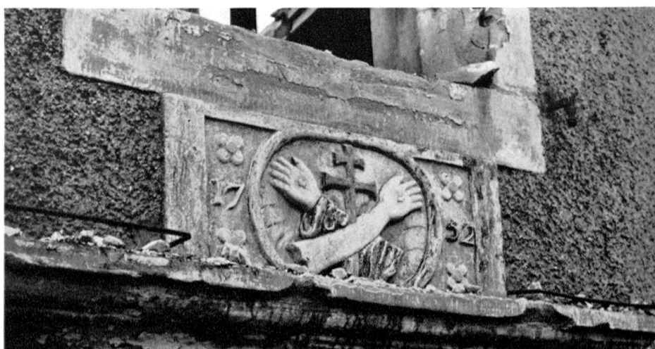
La Cure de Font pendant la démolition: Relief daté 1752, aux armes des Cordeliers, au-dessus de la porte
