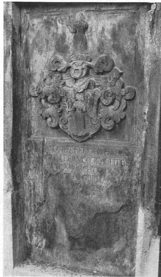
Links: Grabtafel Nr. 48 (vom Eingang gezählt) aus Scalärastein im Scalettafriedhof in Chur, datiert 1688. Aufnahme 1936, bereits erhebliche Schäden zeigend. Die Einfassung im Grundfeuchtebereich ist in Zementmörtel erneuert. Rechts: Aufnahme der gleichen Tafel im Herbst 1966. Große Ausdehnung der Zerstörung, auch oben. Die Einfassung in Mörtel ergab keinen Schutz
