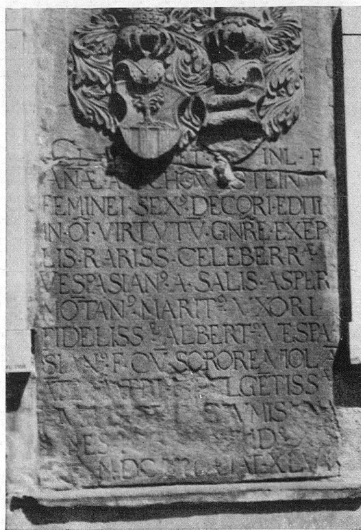
Epitaph Salis-Schauenstein an der Kirche Jenins aus einem Kalkschiefer, entsprechend Scalärastein, datiert 1612. Heutiger Zustand, gegenüber dem vor etwa 30 Jahren fast unverändert (siehe Text). Die Beschädigungen des rechten Wappens und der horizontale Riß oben beruhen nicht auf Grundfeuchtwirkung, sondern auf einer alten Beschädigung der Platte (schon vorhanden in der zitierten Abbildung in den Kdm.)
