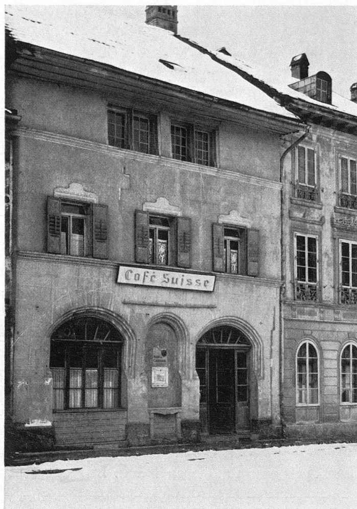
Romont. «Café Suisse», construit en 1576, avant la restauration
