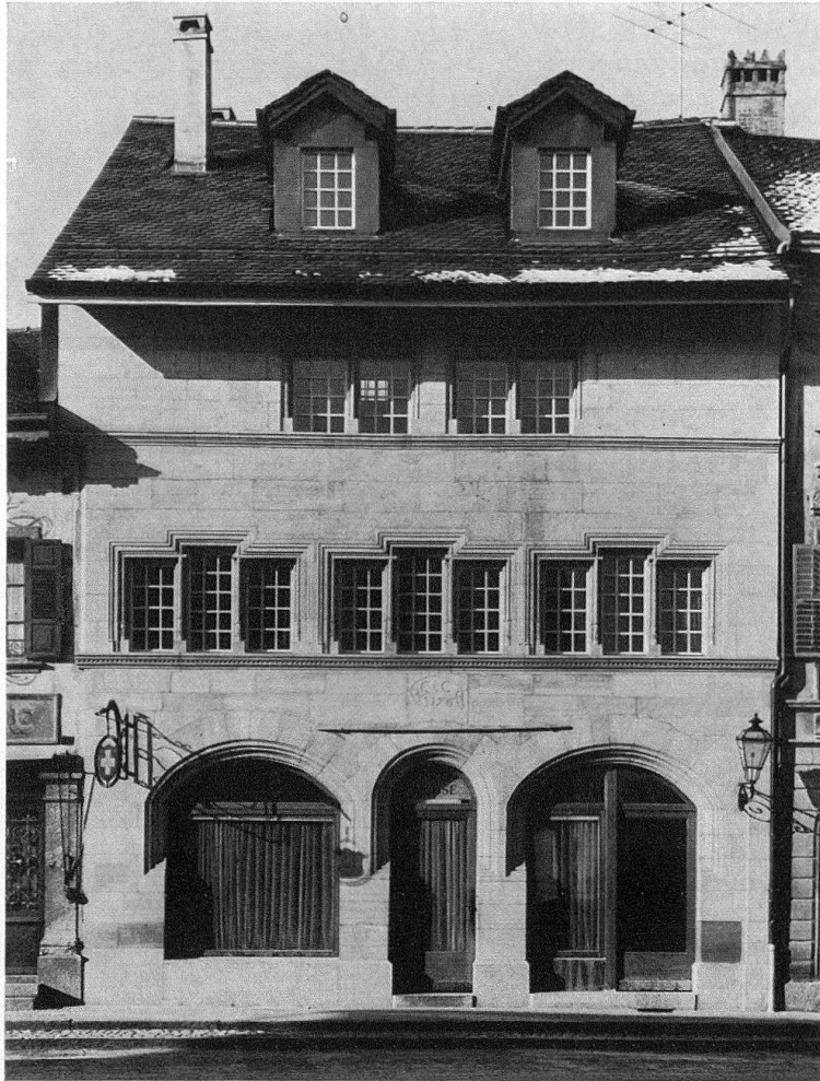
Romont. «Café Suisse», construit en 1576, après la restauration de 1964–1966
