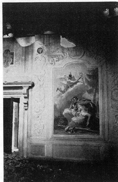
Villa Valmarana: beschädigte Fresken von Tiepolo
